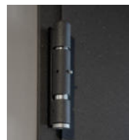
Rys. 12. Zawias standard z regulacją 2D
