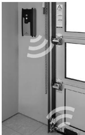
Rys. 41. Bezprzewodowy system transmisji WSD.
