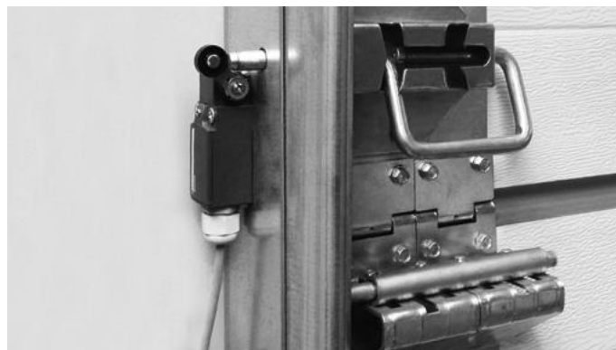
Rys. 38. Przykład montażu czujnika otwarcia zamka/rygla.
