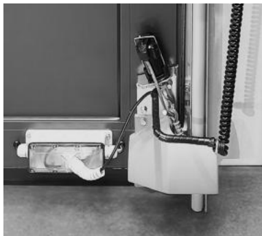
Rys. 33. Czujnik luźnej linki
