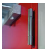
Rys. 16. Zawias ze stali nierdzewnej z regulacją 3D
