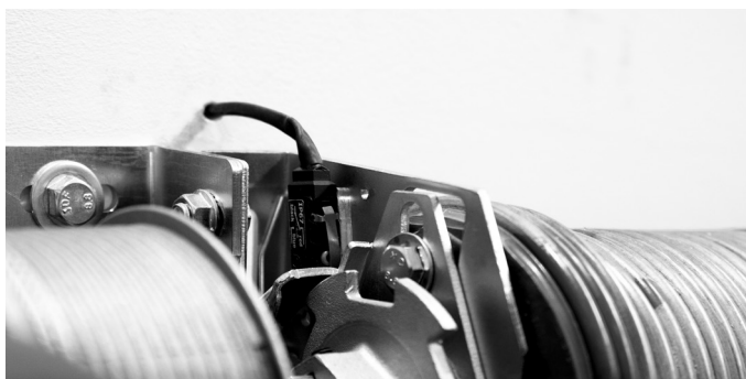
Rys. 34. Czujnik pękniętej sprężyny
