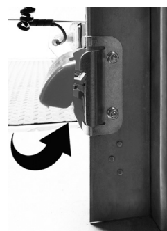
Rys. 6. Zabezpieczenie przed podważeniem skrzydła bramy.
