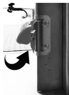
Rys. 6. Zabezpieczenie przed podważeniem skrzydła bramy.
