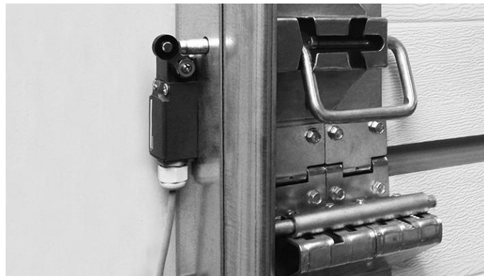
Rys. 36. Przykład montażu czujnika otwarcia zamka/rygla.
