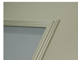
Aplikacja w postaci ramek z profili aluminiowych
