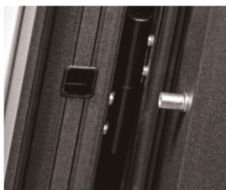
Rys. 13. Bolec przeciwwyważeniowy
