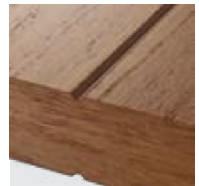
zbliżenie na frezowanie - widoczna struktura podłoża, wąski frez
