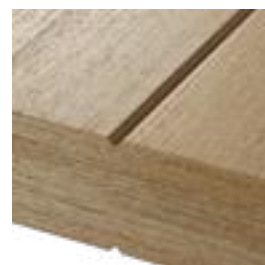
zbliżenie na frezowanie - widoczna struktura podłoża
